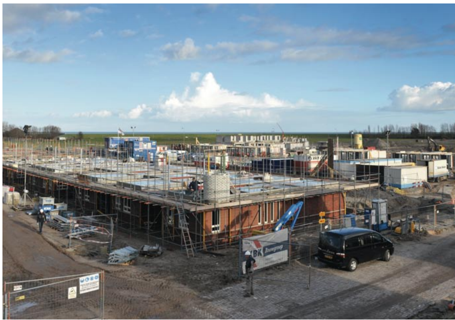
De contouren van de prachtige watervilla's zijn al zichtbaar en de bouw verloopt voorspoedig. Als de weergoden het toelaten, worden volgens de prognose van KBK de eerste woningen in de periode mei t/m juli 2012 opgeleverd!
